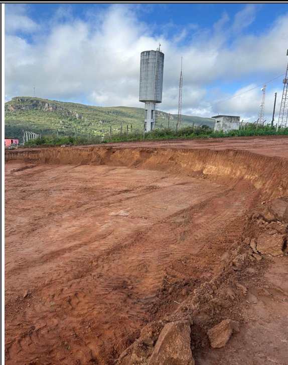
Foto 2: MOVIMENTAÇÃO DE TERRA.
