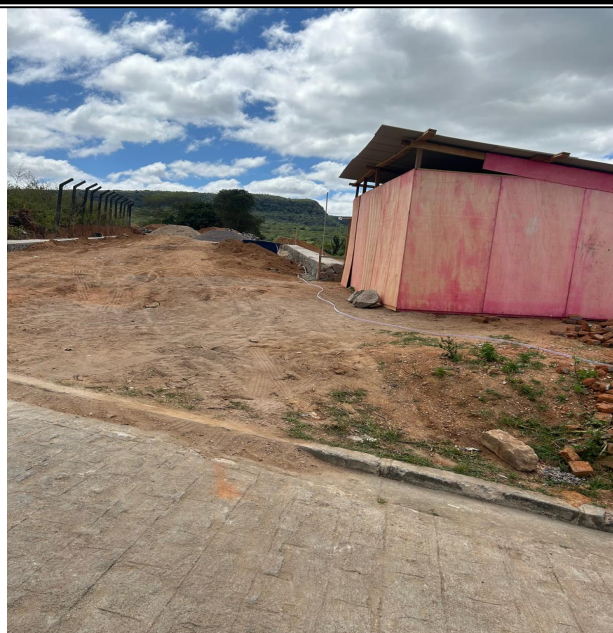
Foto 3: DEPÓSITO DA OBRA.
