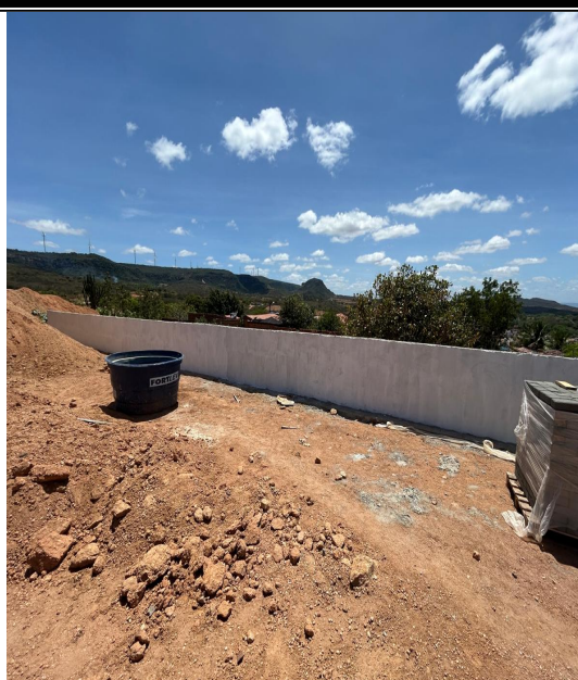
Foto 4: PINTURA DE ALVENARIA.
