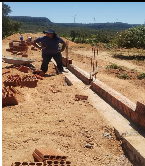
Foto 1: PILARES E ALVENARIA.
