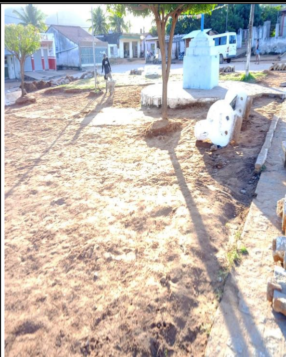
Foto 4: DEMOLIÇÃO DE BANCOS E REMOÇÃO DO MEIO-FIO
