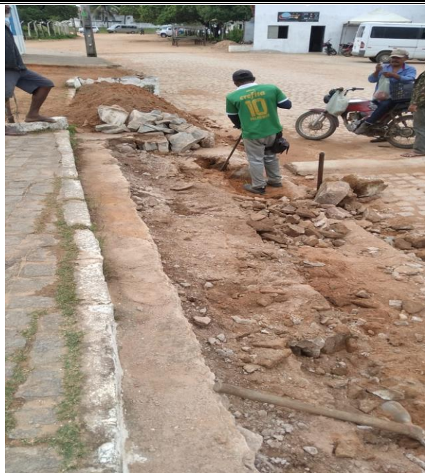
Foto 7 : DEMOLIÇÃO DE ESCADARIA E DE CONTENÇÃO AO LADA DA IGREJA.
