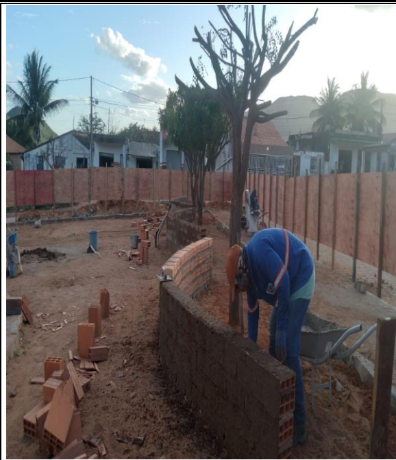
Foto 8: EXECUÇÃO DE BANCOS E CHAPISCO.
