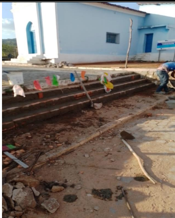
Foto 11: EXECUÇÃO DA ESCADARIA.
