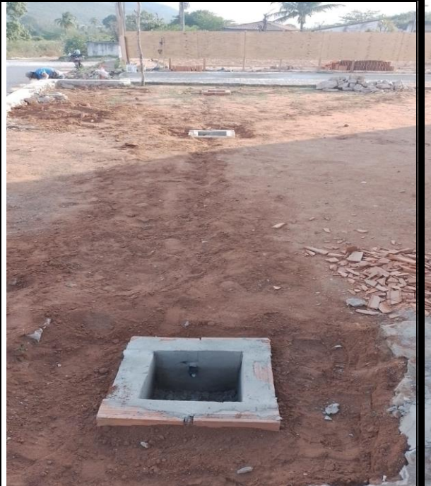
Foto 10: EXECUÇÃO DE CAIXAS DE PASSAGEM PARA ELÉTRICA.
