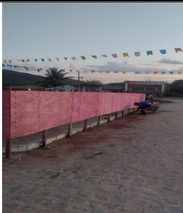
Foto 3: INSTALAÇÃO DE TAPUME.
