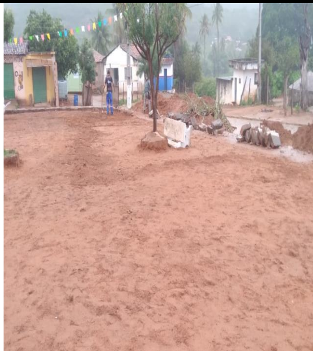
Foto 5: REMOÇÃO DO MEIO-FIO.
