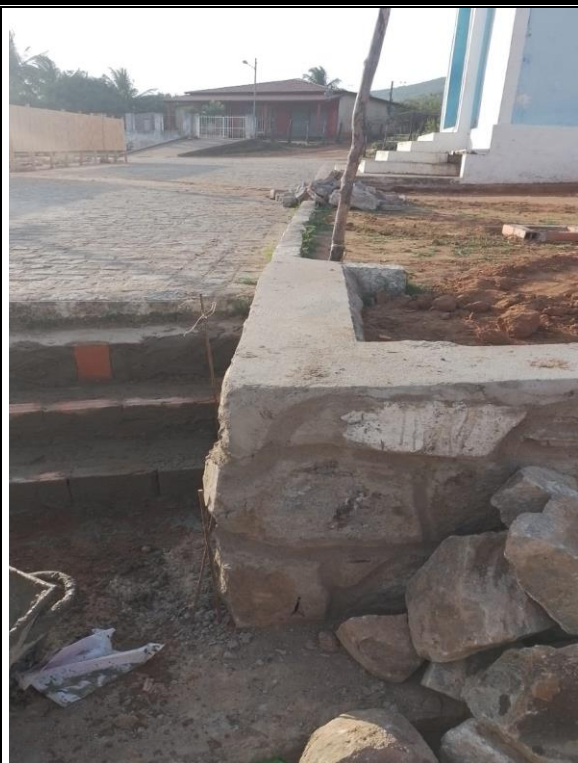
Foto 12: ALONGAMENTO DA CONTENÇÃO.
