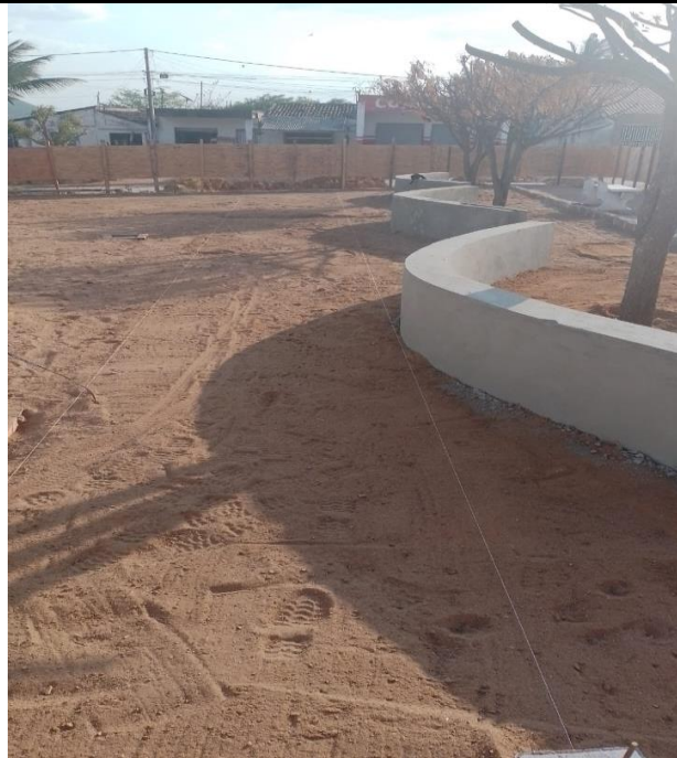
Foto 9 EXECUÇÃO DE REBOCO DOS BANCOS E PLANTIU DAS ÁRVORES.
