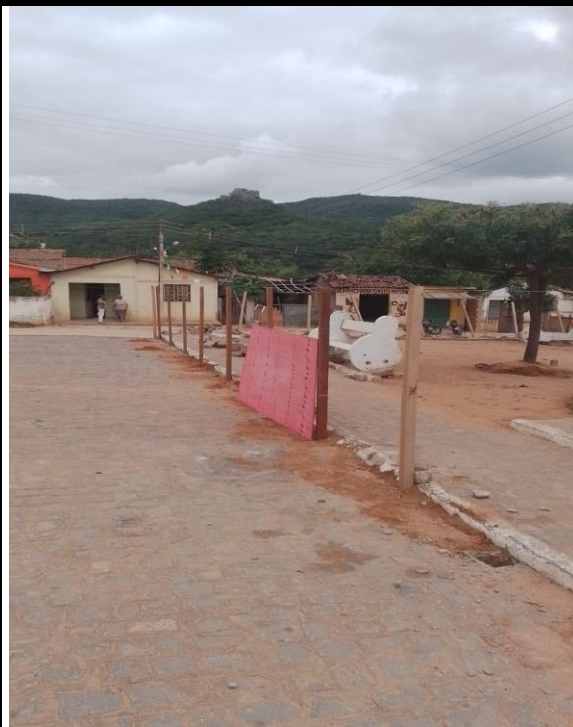
Foto 2: INSTALAÇÃO DE TAPUME.
