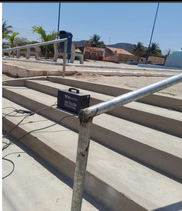
Foto 13: INSTALAÇÃO DE CORRIMÃO.
