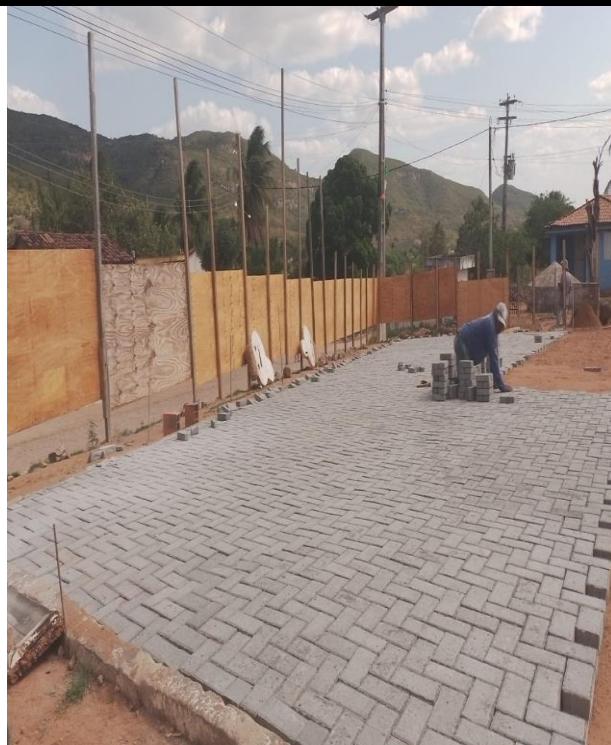
Foto 1: ASSETAMENTO DE INTERTRAVADO.
