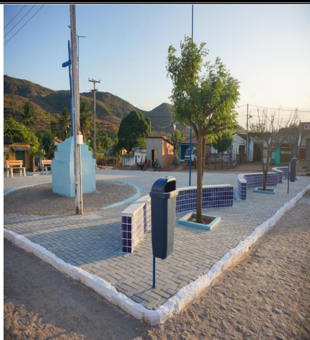
Foto 15: PINTURA DE MEIO-FIO.
