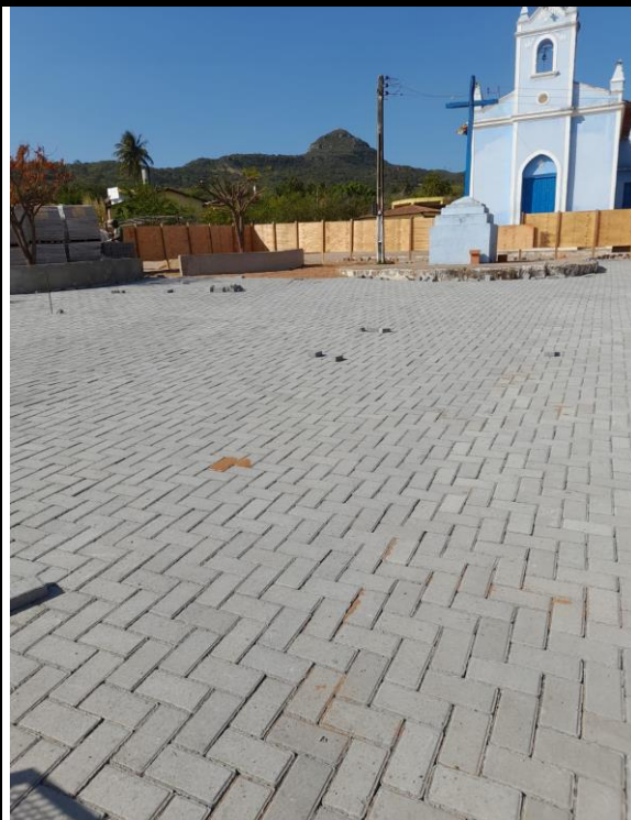
Foto 2: ASSETAMENTO DE INTERTRAVADO.
