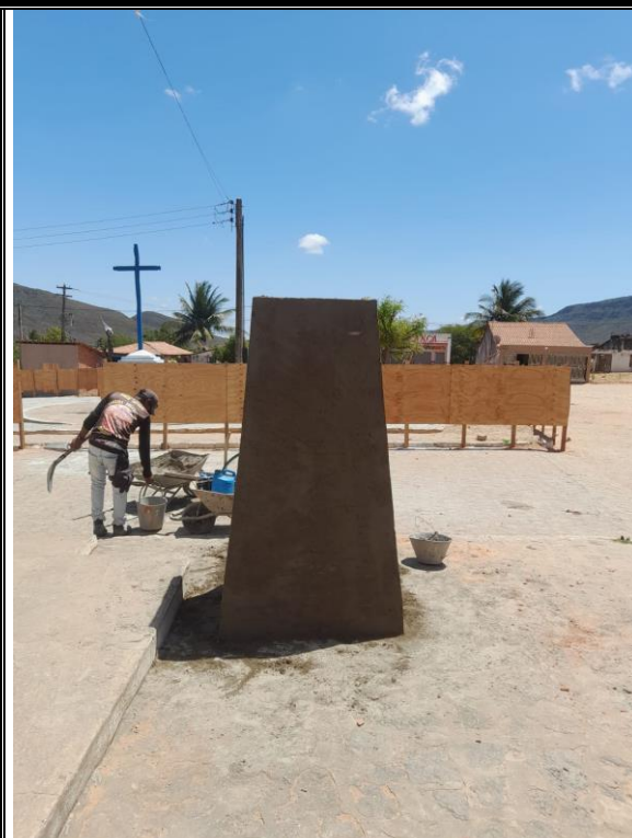
Foto 6: REBOCO DA BASE.
