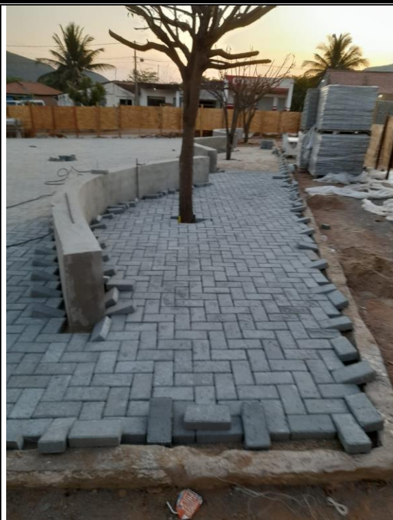
Foto 4: ASSETAMENTO DE INTERTRAVADO.
