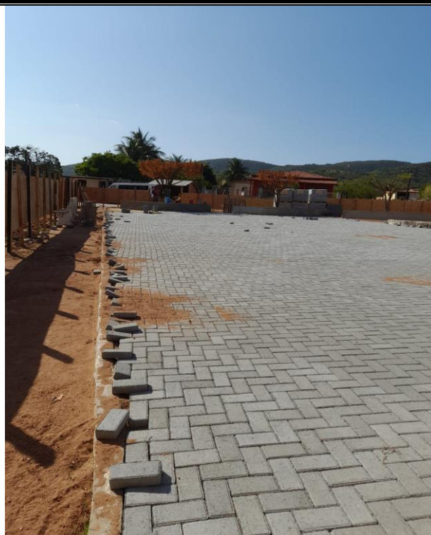
Foto 3: ASSETAMENTO DE INTERTRAVADO.
