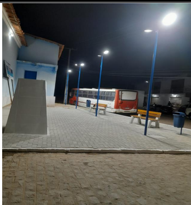
Foto 11: INSTALAÇÃO DOS POSTES LATERAIS A IGREJA E REVESTIMENTO NAS BASES.
