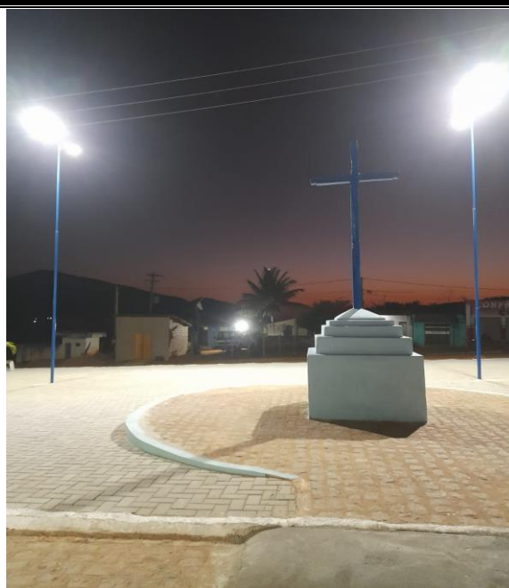
Foto 12: INSTALAÇÃO DOS POSTES CENTRAIS DA PRAÇA.
