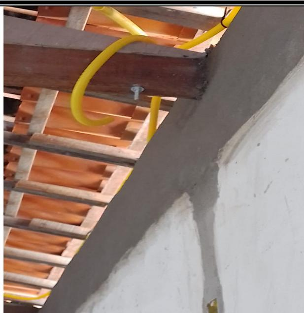
Foto 5: SUBSTITUIÇÃO DE PARAFUSOS DA TESOURA.
