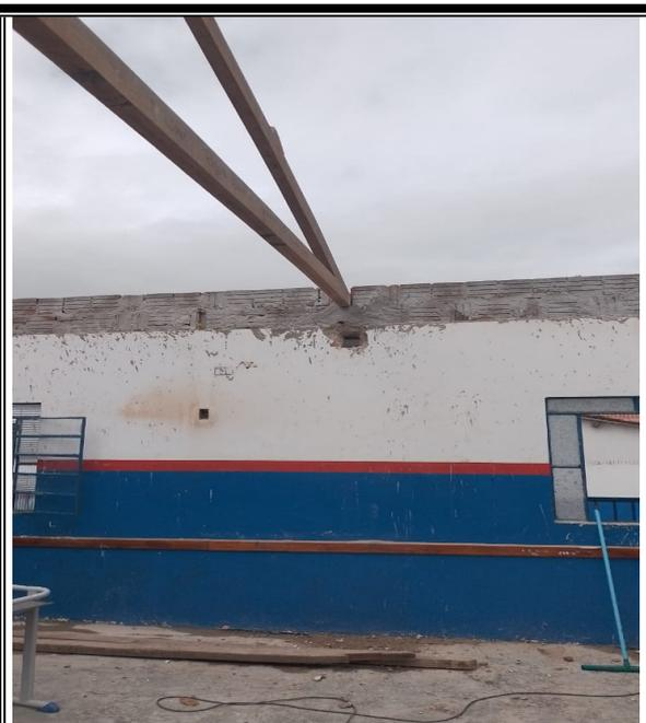
Foto 2: REMOÇÃO DE TELHAS E ESTRUTURA DE MADEIRA.
