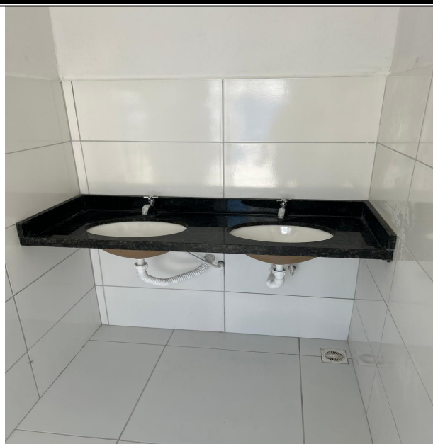
Foto 5: BANCADA, LAVATÓRIOS E RESVESTIMENTO CERAMICO DO BANHEIRO.
