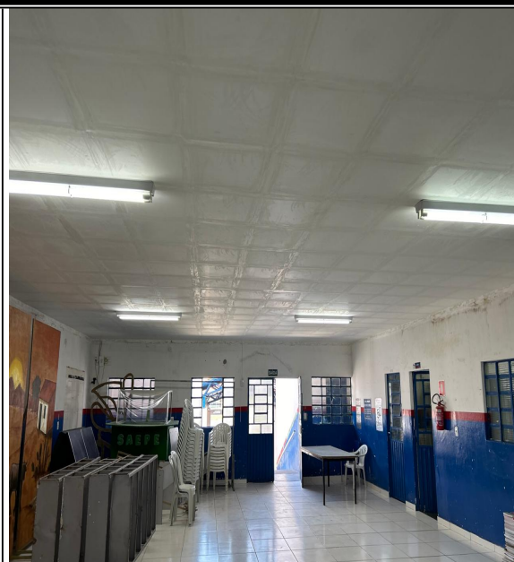
Foto 6: FORRO DE GESSO DO AUDITÓRIO E LUMINARIAS.
