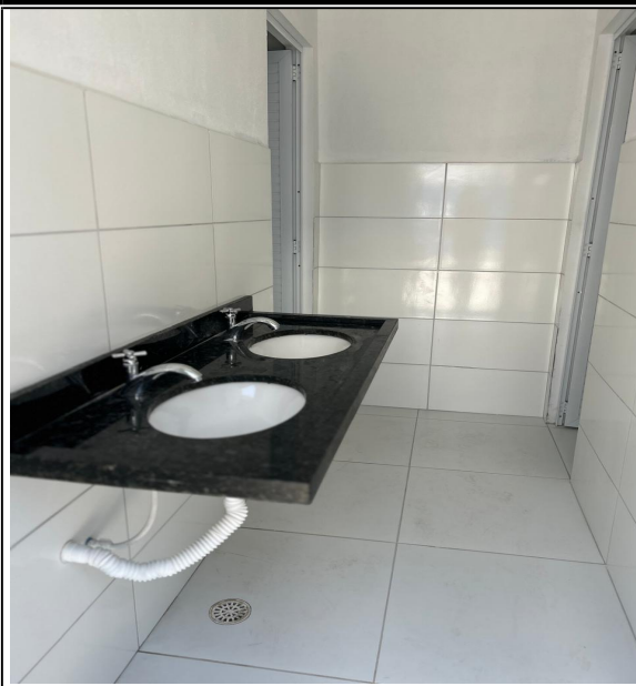
Foto 4: BANCADA, LAVATÓRIOS E RESVESTIMENTO CERAMICO DO BANHEIRO.
