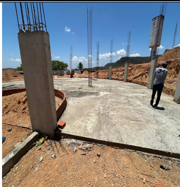
Foto 7: LAJE DE PISO.
