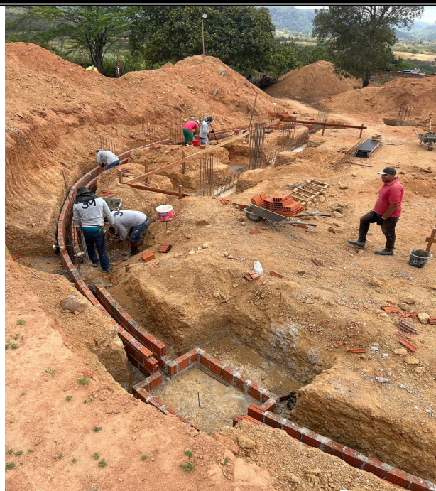
Foto 5: FORMA DE VIGA BALDRAME.
