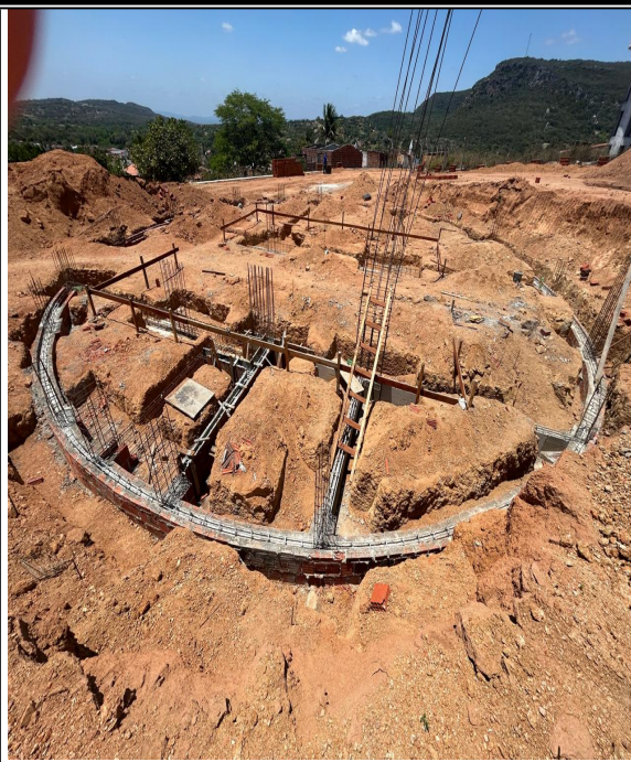
Foto 6: CONCRETAGEM DE VIGA BALDRAME.
