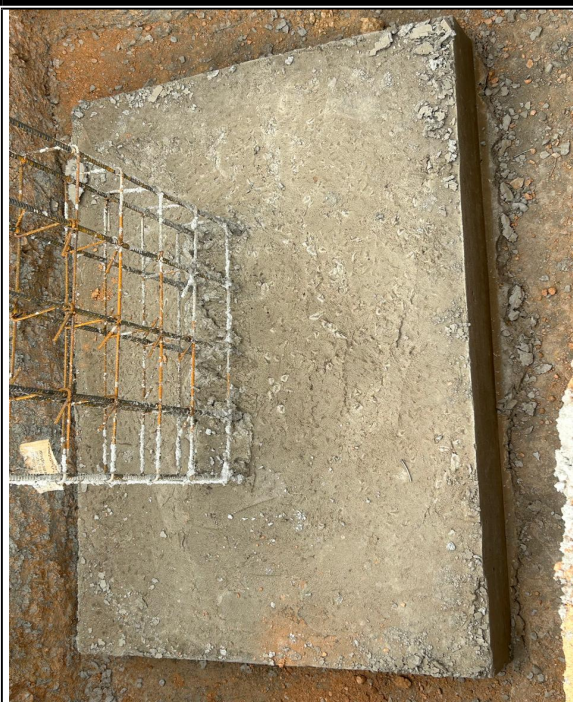
Foto 4: SAPATA CONCRETADA.
