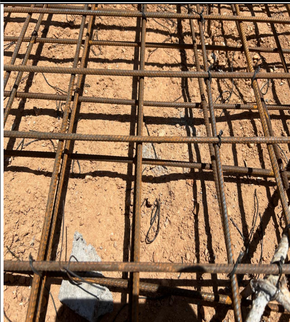
Foto 8 ARMADURA DA LAJE DO PISO.
