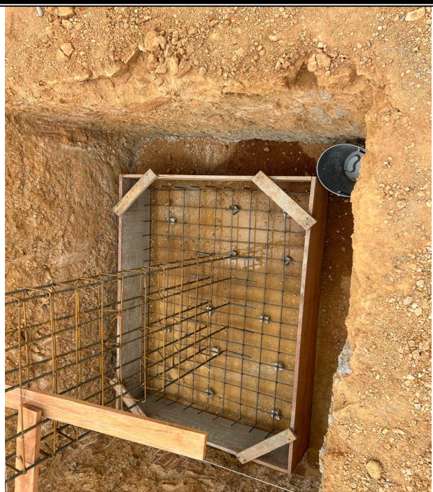
Foto 3: ARMADURA DA SAPATA.
