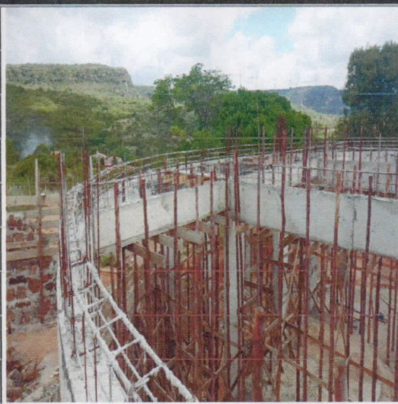
Foto 6: CONCRETAGEM DE VIGAS.
