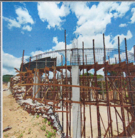
Foto 2: ARMADURA DE VIGAS E SIMBRAMENTO.
