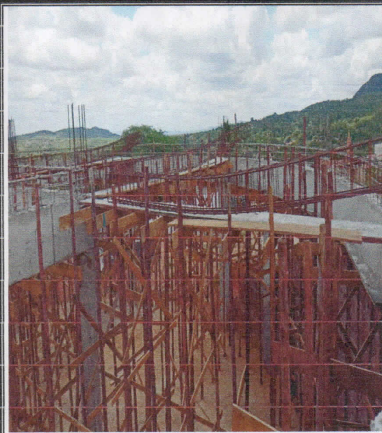
Foto 4: ARMADURA DE VIGA E SIMBRAMENTO.
