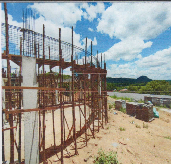
Foto 1: ARMADURA DE VIGAS E SIMBRAMENTO.
