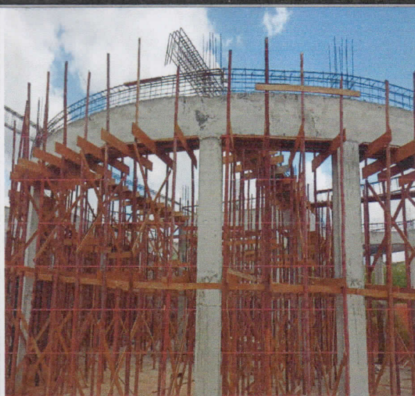
Foto 5: CONCRETAGEM DE VIGAS.
