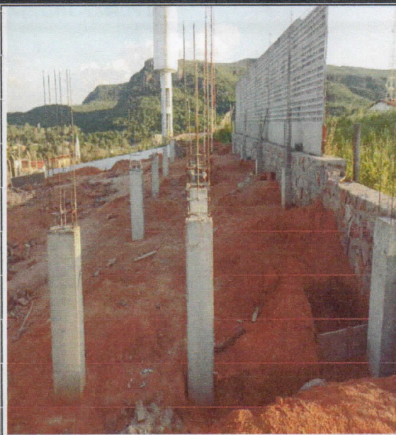
Foto 8: CONCRETAGEM SAPATAS E ARRANQUES.
