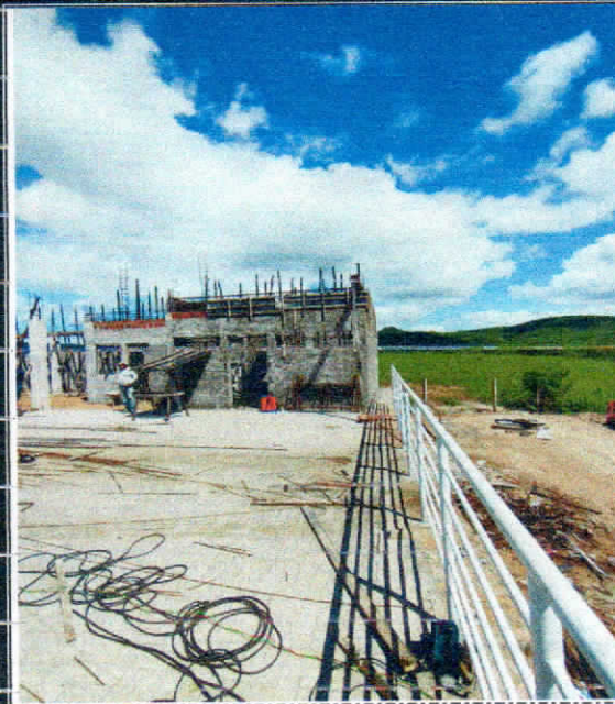
Foto 8: ALVENARIA DO QUIOSQUE
