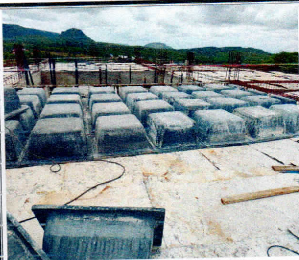
Foto 1: FORMAS DA LAJE.
