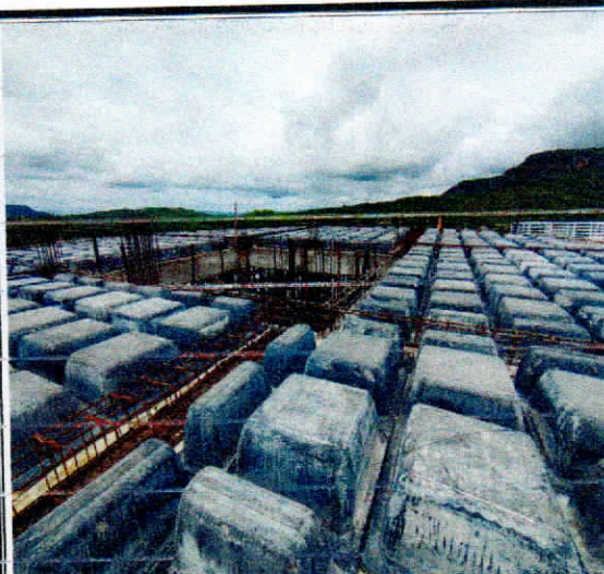
Foto 2: FORMAS DA LAJE.
