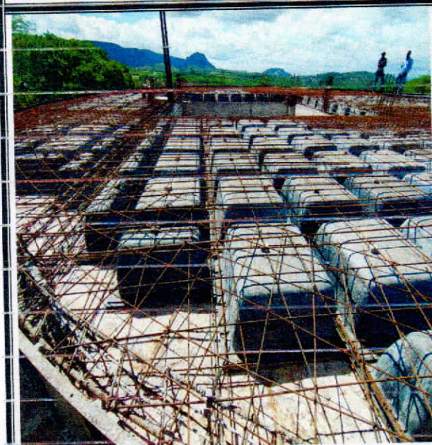
Foto 3: ARMADURA LAJE CAPELA.
