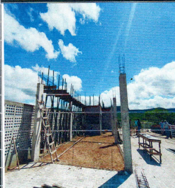
Foto 7: PILARES E VIGAS DO QUIOSQUE.
