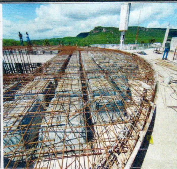
Foto 5: ARMADURA LAJE CAPELA.
