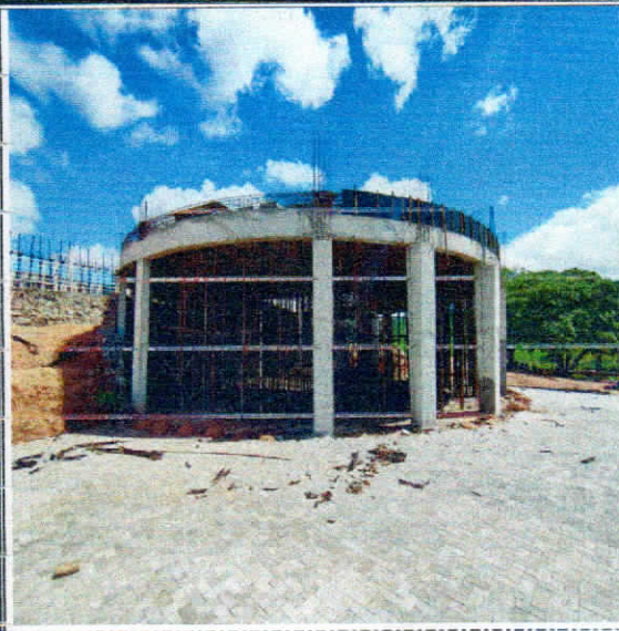
Foto 6: FORMAS DE VIGAS.
