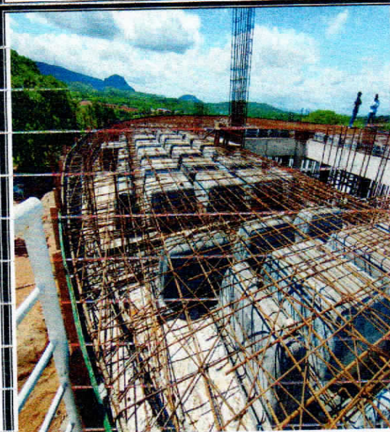
Foto 4: ARMADURA LAJE CAPELA.
