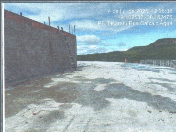
Foto 6: DESFORMAS DA LAJE E VIGAS.
