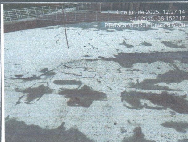
Foto 1: LAJE CONCRETADA EM CURA
