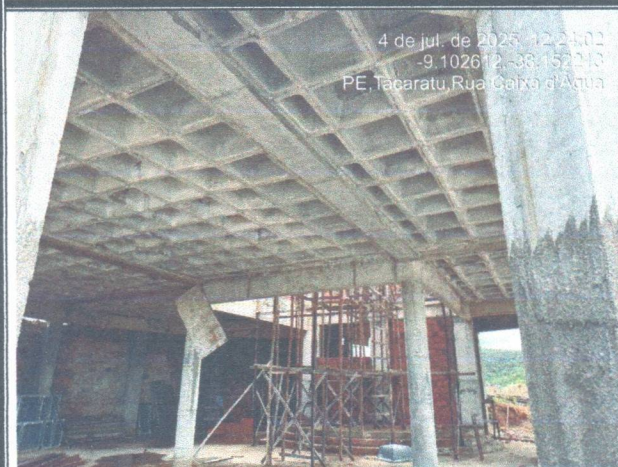
Foto 5: CONCRETAGEM DA LAJE.
