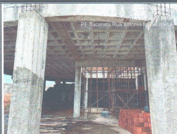
Foto 6: DESFORMAS DA LAJE E VIGAS.
