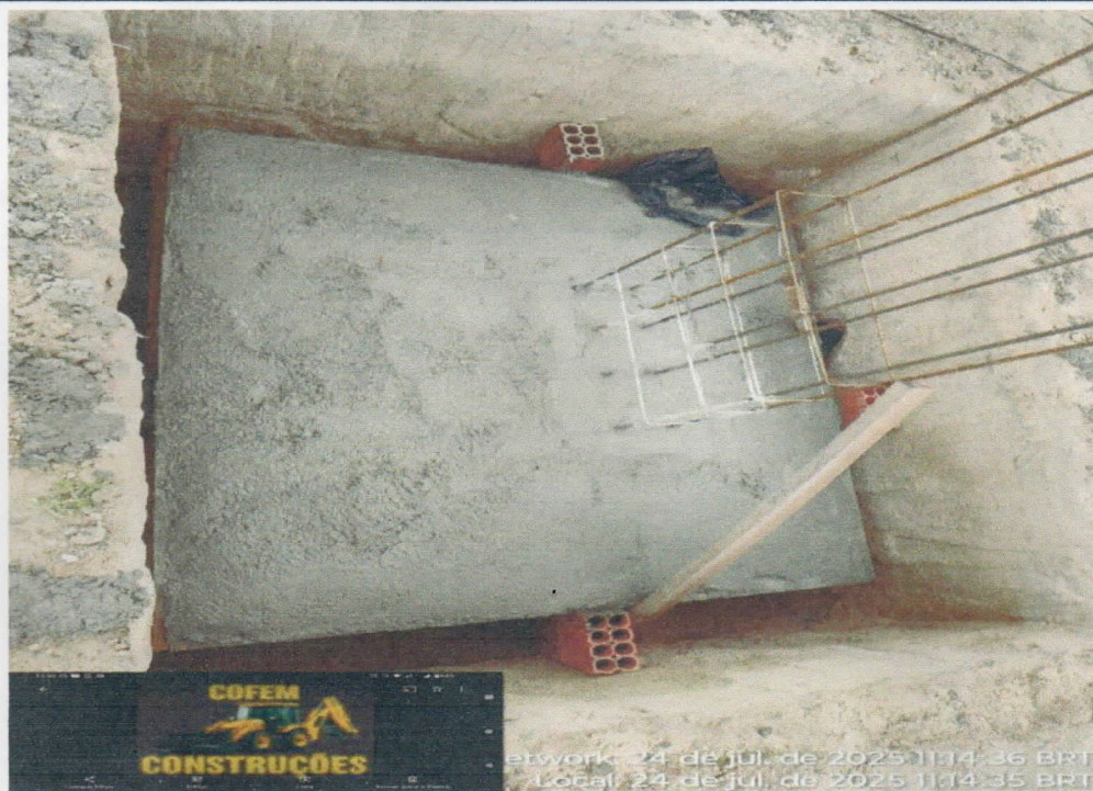
DESCRIÇÃO: EXECUÇÃO DAS VIGAS BALDRAME
