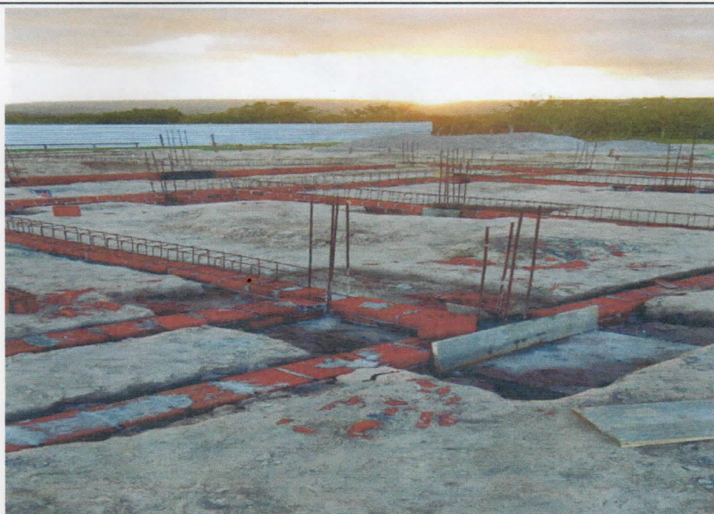
DESCRIÇÃO: EXECUÇÃO DAS VIGAS BALDRAME
