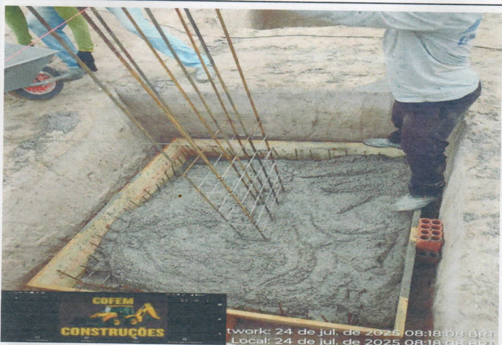
DESCRIÇÃO: CONCRETAGEM DAS SAPATAS
