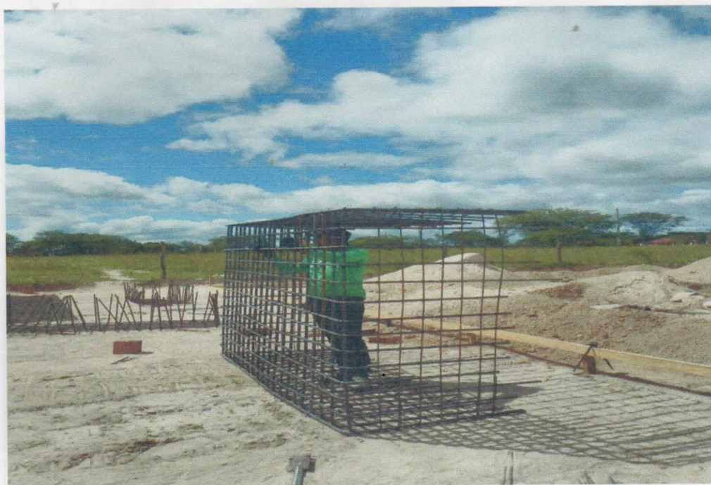
DESCRIÇÃO: ARRANQUE DOS PILARES
