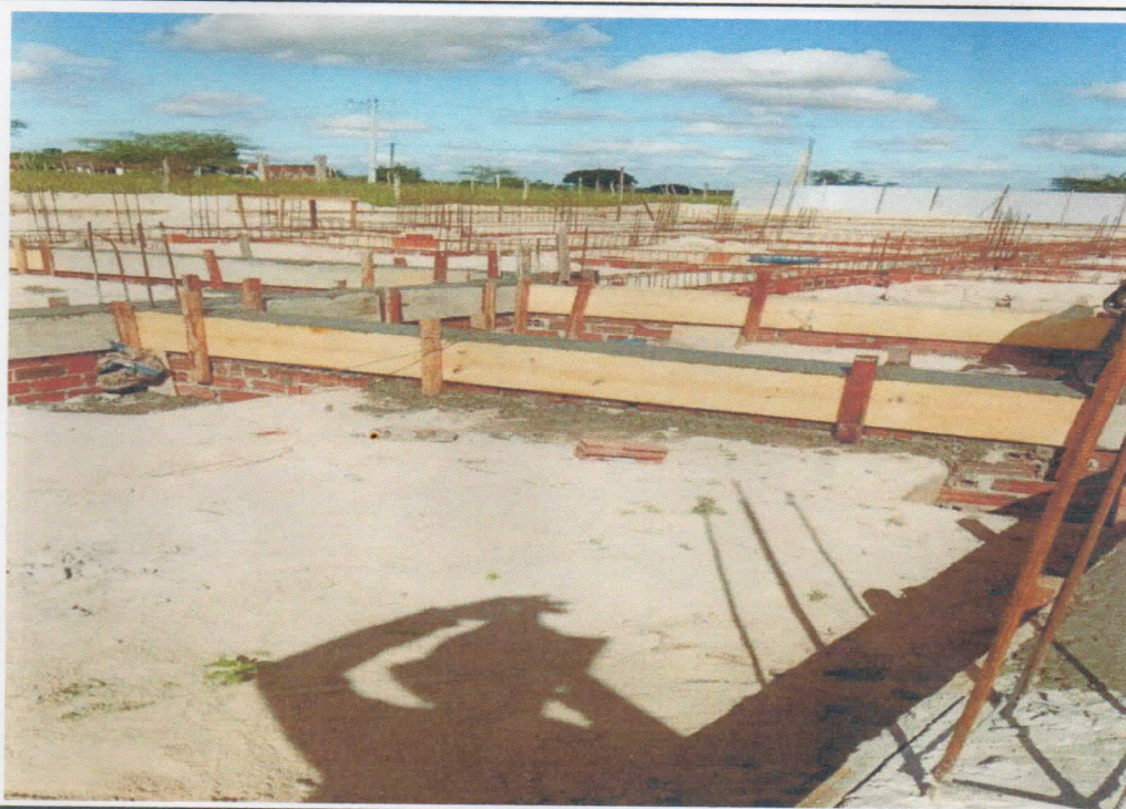
DESCRIÇÃO: EXECUÇÃO DAS VIGAS BALDRAME
