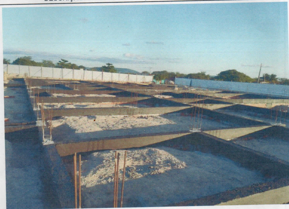
DESCRIÇÃO: IMPERMEABILIZAÇÃO DAS VIGAS BALDRAMES
