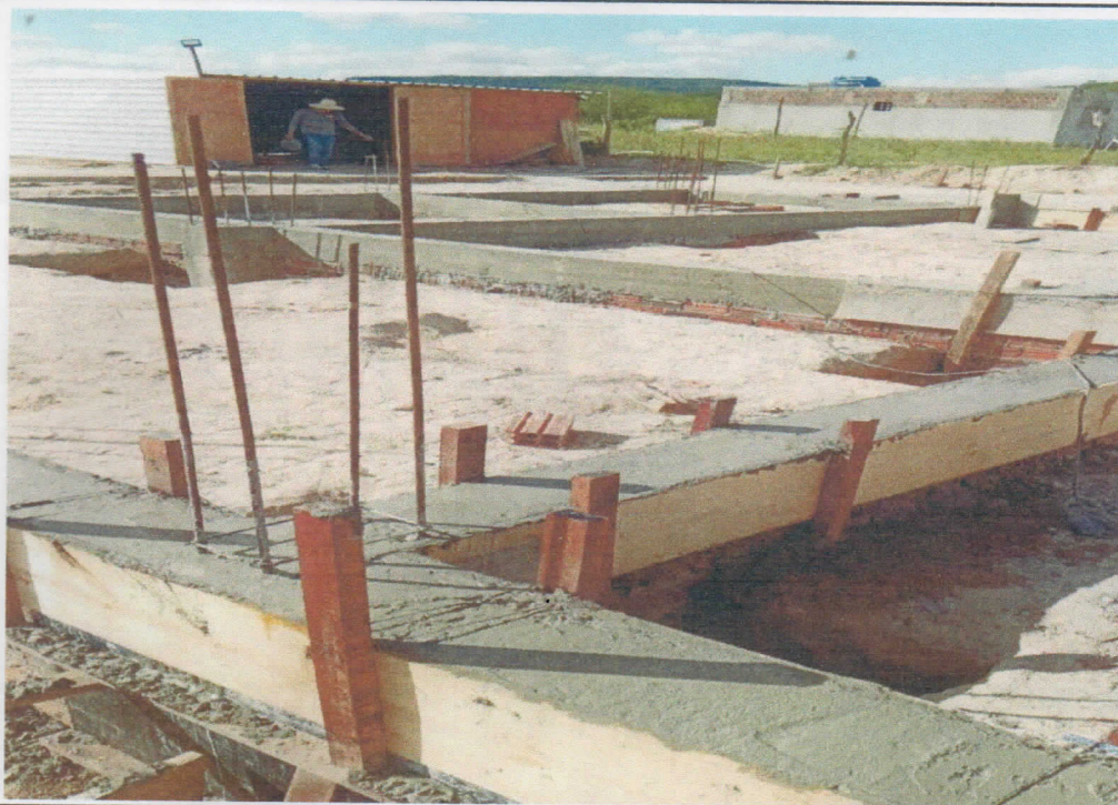
DESCRIÇÃO: EXECUÇÃO DAS VIGAS BALDRAME
