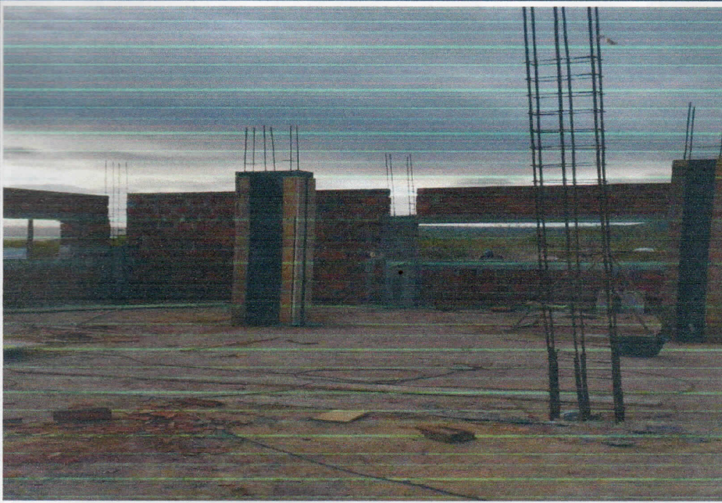
DESCRIÇÃO: ALVENARIA E INICIO DA CONCRETAGEM DOS PILARES
