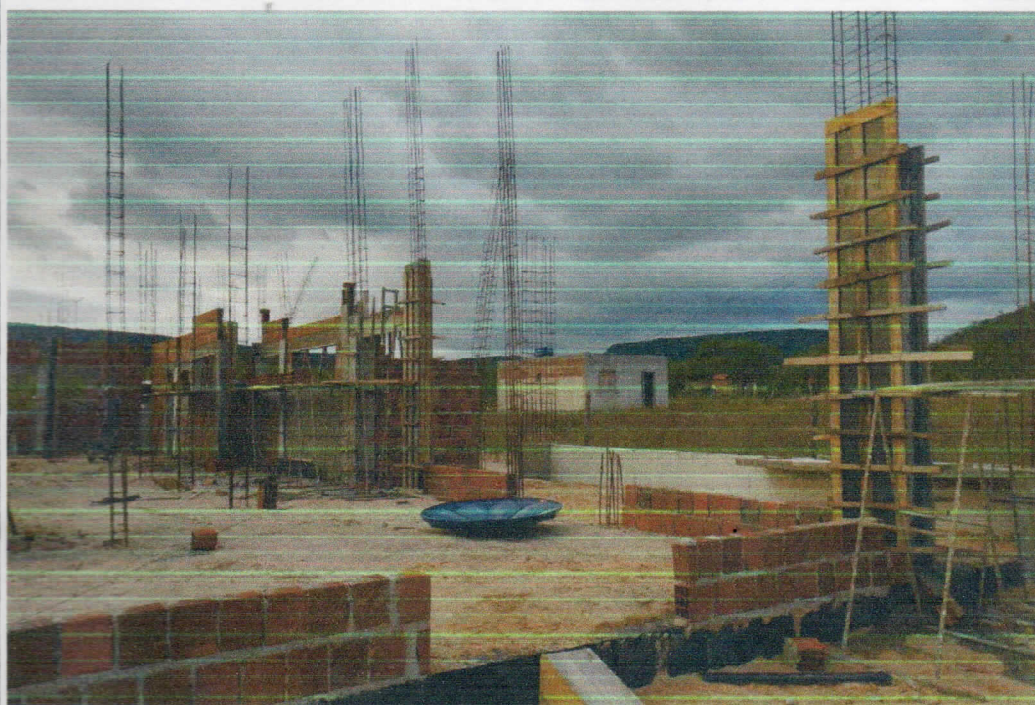
DESCRIÇÃO: ALVENARIA E INICIO DA CONCRETAGEM DOS PILARES
