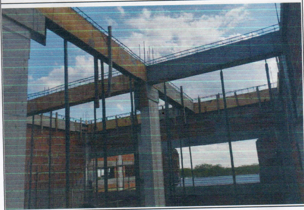
DESCRIÇÃO: CONCRETAGEM DAS VIGAS
