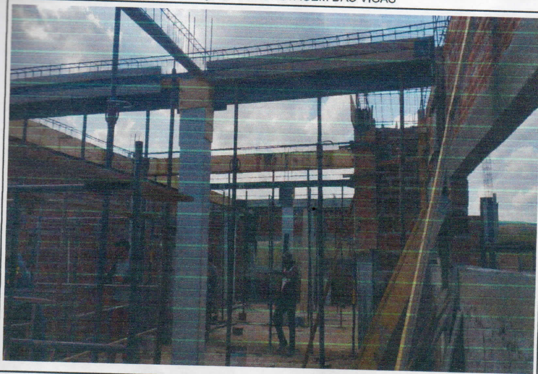
DESCRIÇÃO: CONCRETAGEM DAS VIGAS
