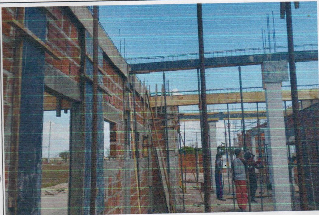
DESCRIÇÃO: CONCRETAGEM DAS VIGAS
