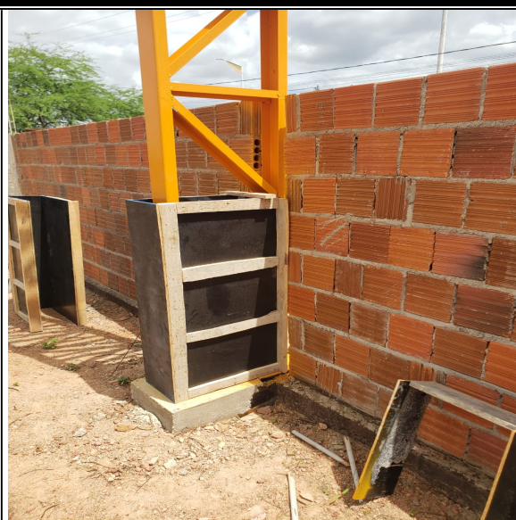
Foto 10: CONCRETAGEM PILARES.
