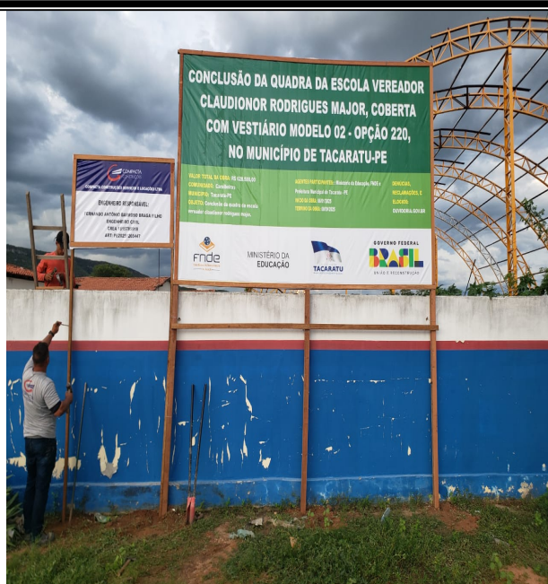
Foto 1: PLACA DE OBRA.
