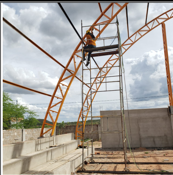
Foto 14: PINTURA DE ESTRUTURA METÁLICA.
