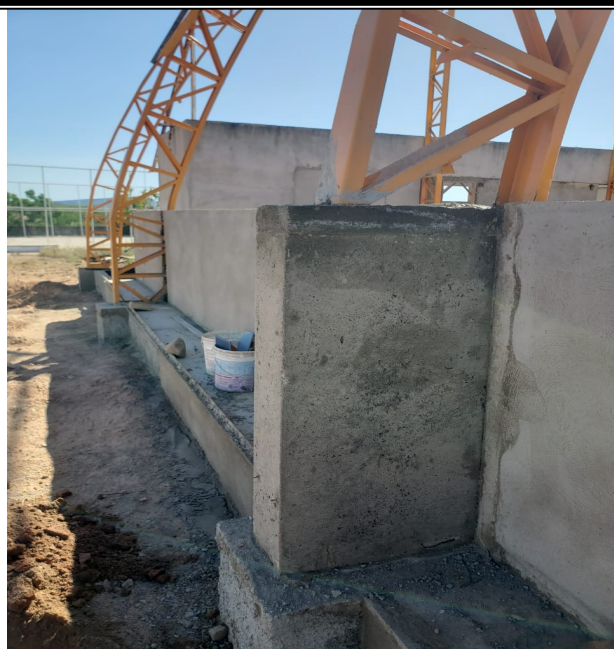
Foto 11: CONCRETAGEM PILARES.
