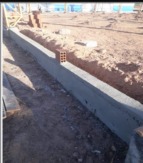
Foto 2: CONCRETAGEM VIGA BALDRAME.
