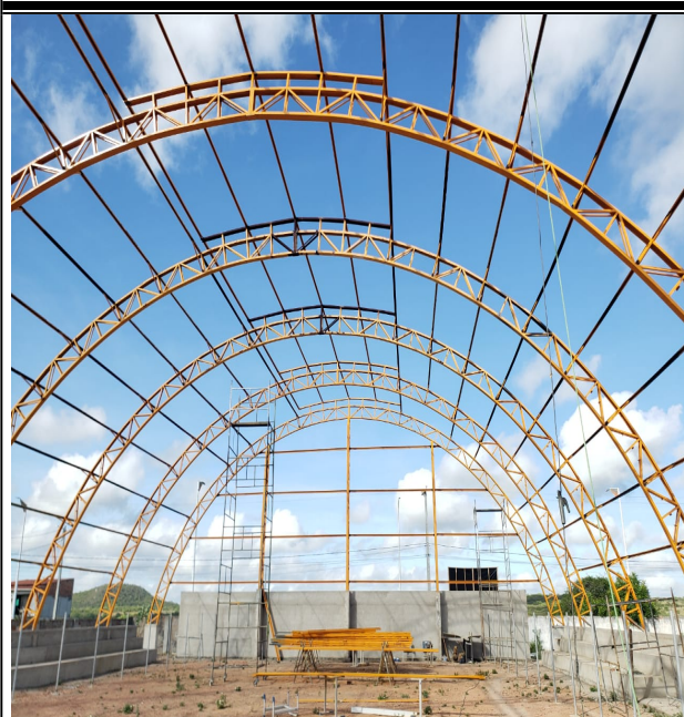
Foto 15: PINTURA DE ESTRUTURA METÁLICA.
