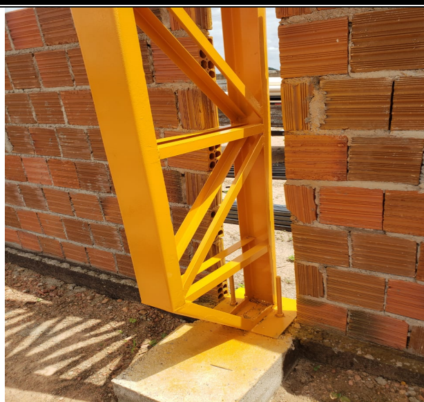
Foto 9: PINTURA DE ESTRUTURA METÁLICA.
