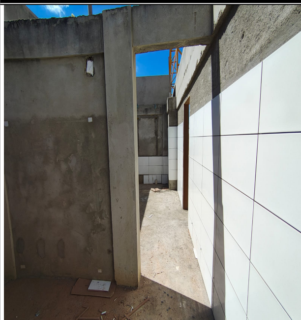
Foto 7: REVESTIMENTO CERAMICO.
