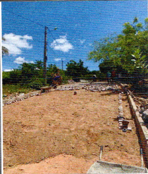
Foto 6: ASSENTAMENTO DA PEDRA.
