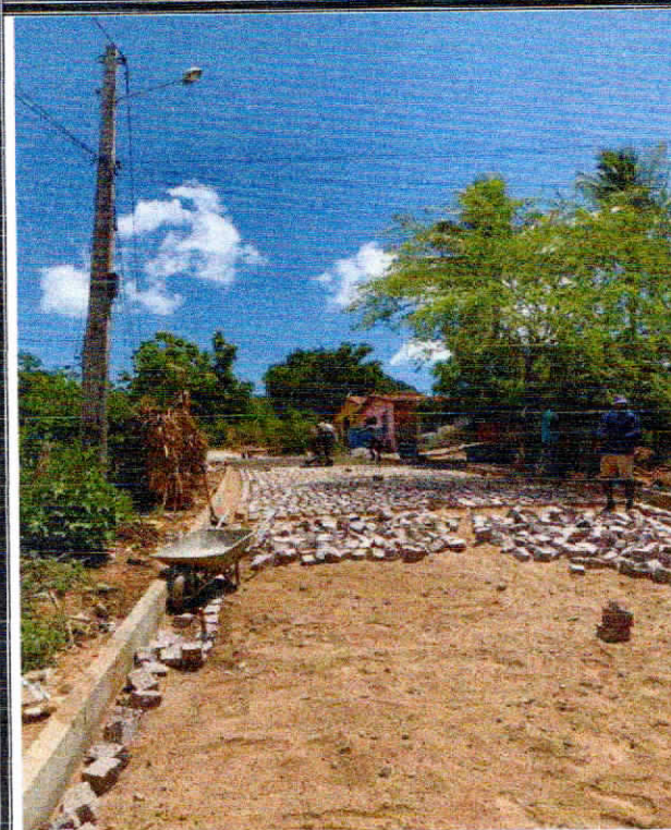
Foto 7: ASSENTAMENTO DA PEDRA.
