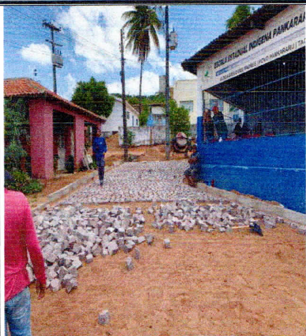
Foto 5: ASSENTAMENTO DA PEDRA.
