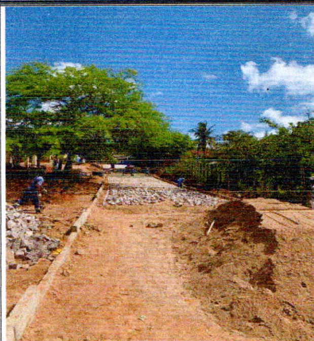
Foto 7: ASSENTAMENTO DA PEDRA.
