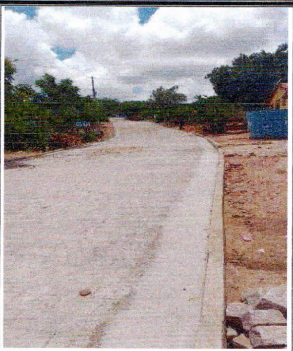
Foto 8: EXECUÇÃO DE SARJETAS.
