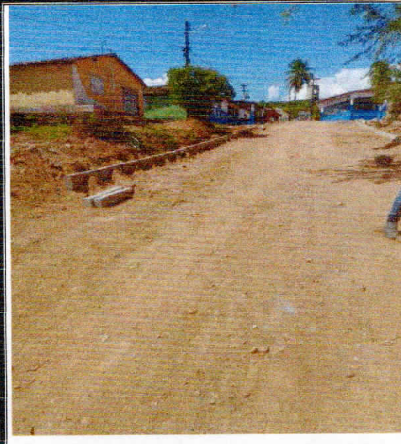
Foto 4: INSTALAÇÃO DE MEIO FIO.
