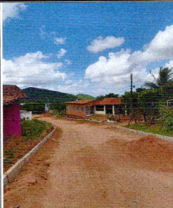
Foto 6: INSTALAÇÃO DE MEIO FIO.
