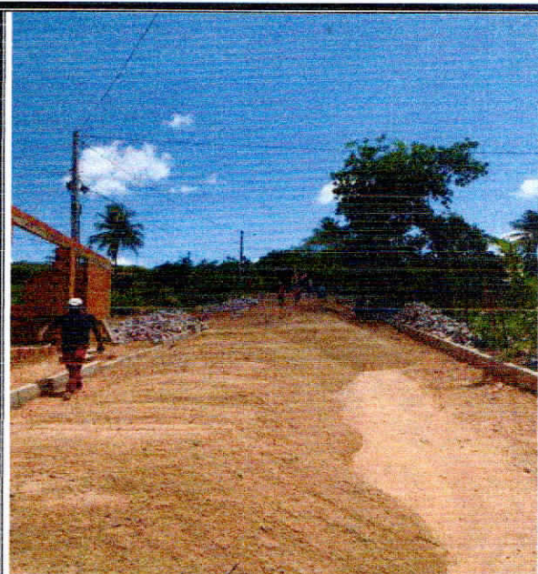
Foto 6: PREPARAÇÃO PARA RECEBER A PEDRA GRANÍTICA.
