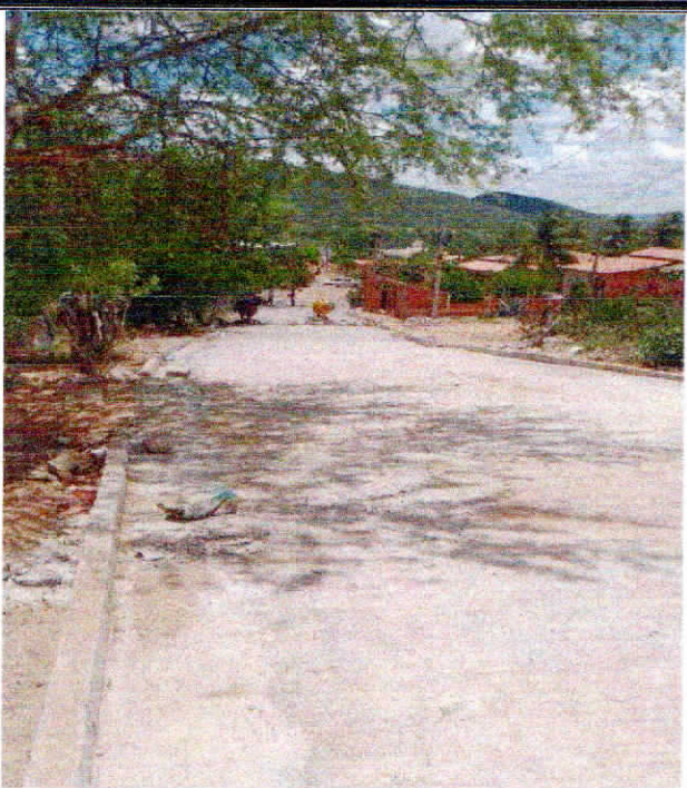
Foto 7: EXECUÇÃO DE SARJETAS.
