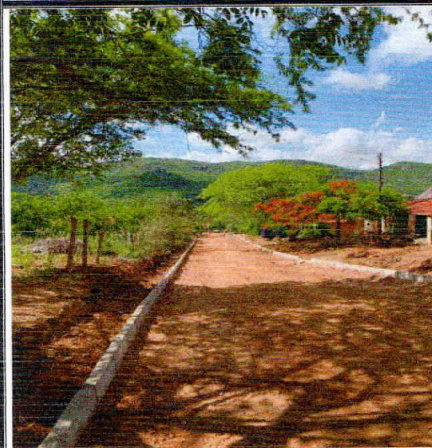
Foto 3: INSTALAÇÃO DE MEIO FIO.
