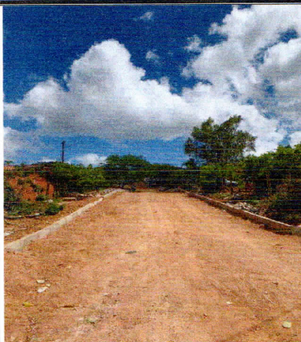
Foto 5: INSTALAÇÃO DE MEIO FIO.
