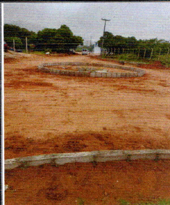
Foto 8: INSTALAÇÃO DE MEIO FIO.
