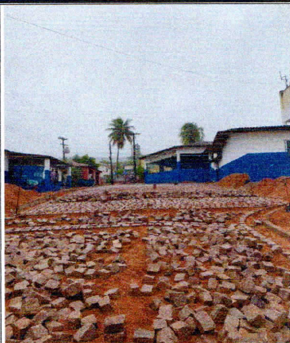
Foto 6: ASSENTAMENTO DA PEDRA.
