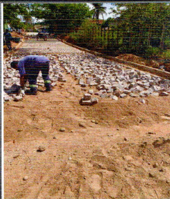
Foto 8: ASSENTAMENTO DA PEDRA.
