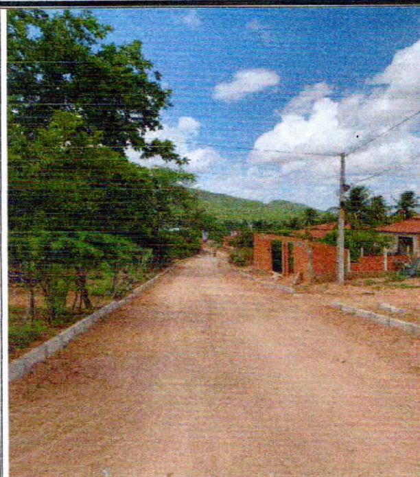
Foto 7: INSTALAÇÃO DE MEIO FIO.
