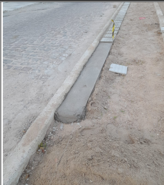
Foto 2: LASTRO DE CONCRETO.
