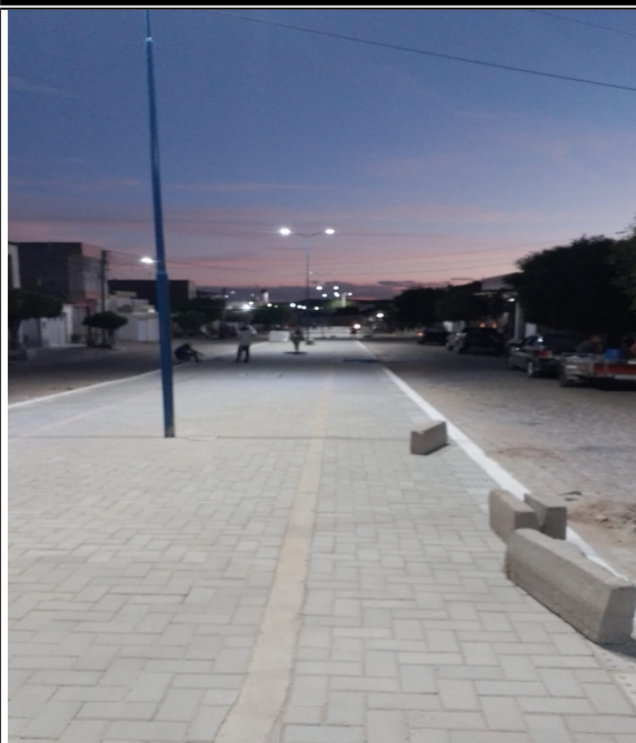
Foto 8: POSTES E LUMINÁRIAS.
