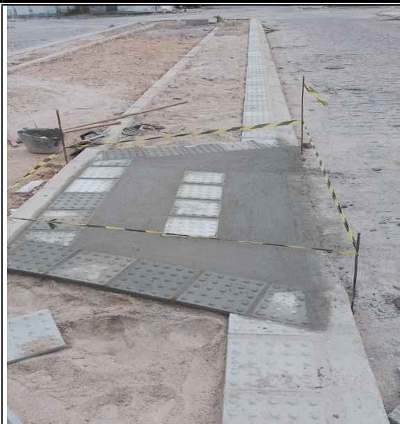
Foto 4: RAMPA DE ACESSIBILIDADE.
