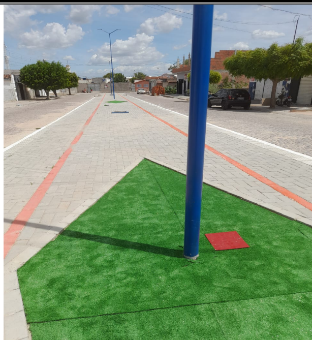
Foto 7: POSTES E LUMINÁRIAS.
