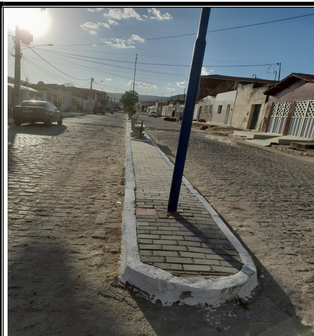
Foto 5: POSTES E PISO INTERTRAVADO.
