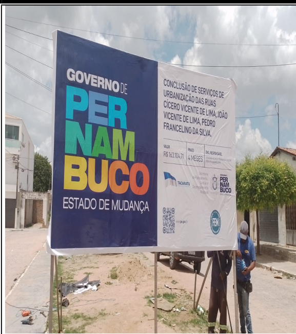
Foto 8: PLACA DE OBRA.
